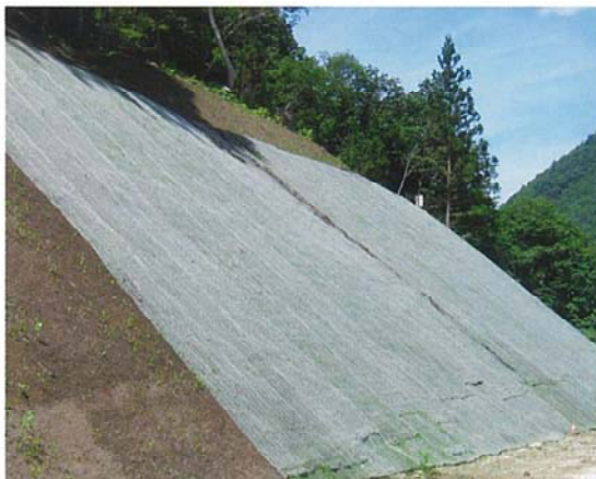
MF-45R-10wn 施工直後
