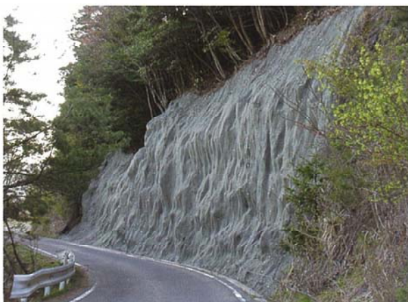
SP-45wn 施工直後
